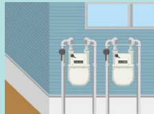
ガスメーター Gas meter
